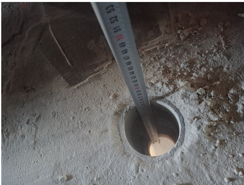
Fot. 2. Miejsce wykonania odwiertu kontrolnego w celu zbadania istniejących warstw stropu
