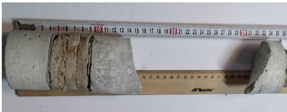
Fot. 1. Przekrój przez strop – próbka pobrana podczas wykonania odwiertu
